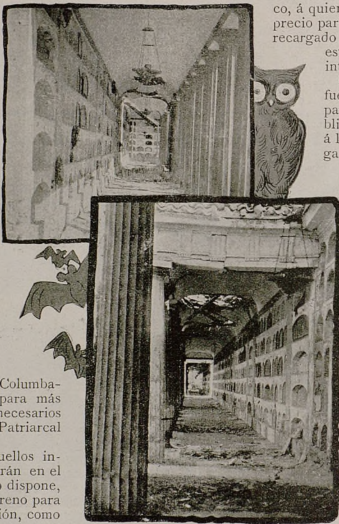
Galerías ruinosas del Cementerio de La Patriarcal. - (Fot. Terol.)
