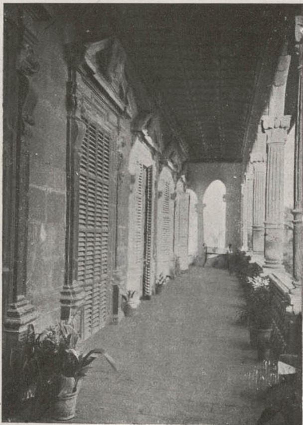
Claustro del edificio del Museo.
