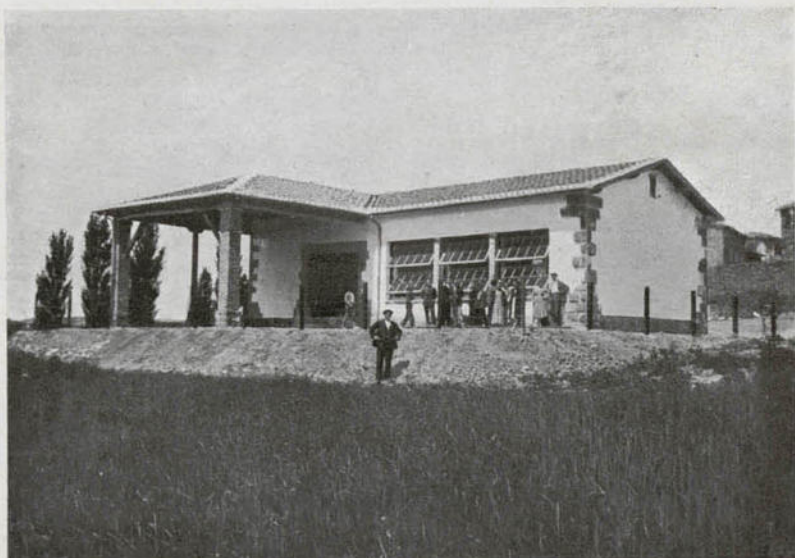
Navaridas (Rioja alavesa). - Grupo escolar de una aula. Inaugurado en 1934. Pertenece al plan de la Diputación. Tiene, además de una aula, vestíbulo, ropero, retretes, lavabos, cuarto para el maestro, patio cubierto y patio descubierto y calefacción central por agua caliente. Fachada al mediodía.
