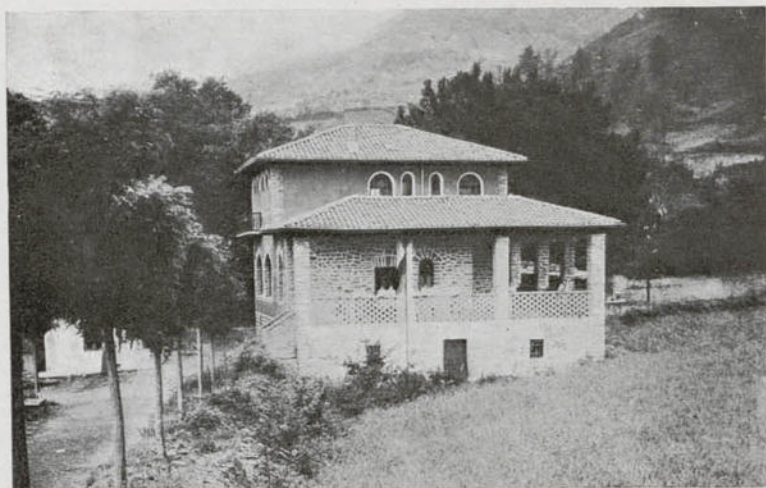
Respaldiza (Ayala). - Escuela de niñas, inaugurada en 1932. Costeada por el pueblo. Tipo vasco. Tiene casa-habitación en el segundo piso. Posee patio cubierto, hermosa aula y cuarto para material. Se ven las fachadas norte y oeste.
