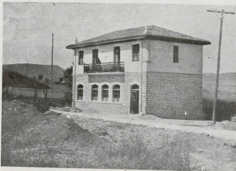
Arechavaleta (Vitoria). - Escuela mixta. Tiene aula, vestíbulo y cuarto de material. Encima, la casa-habitación. Fachada este y norte. Construida por el Ayuntamiento de Vitoria.
