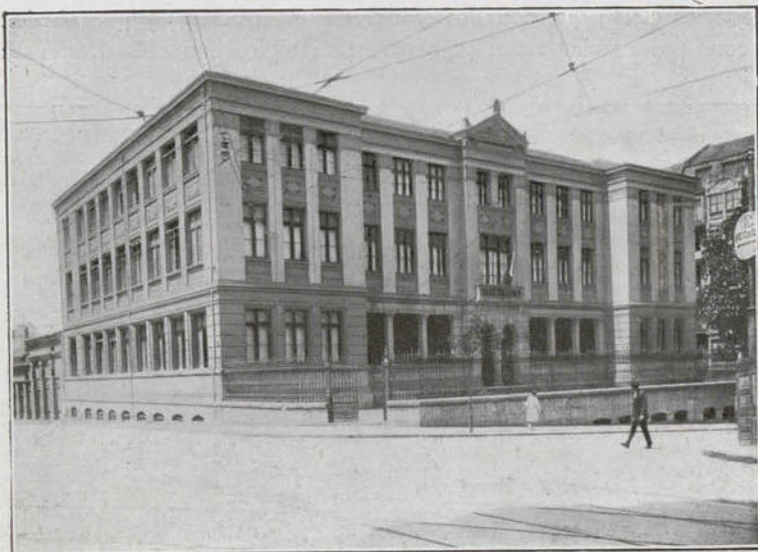
Fachada del Grupo escolar de Concha.
