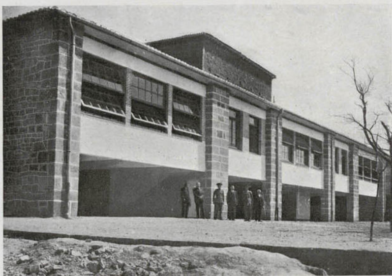
Labastida (Rioja alavesa). - Grupo escolar de tres aulas, inaugurado en 1934. Perteneció al plan de la Diputación. Tiene tres aulas, patios cubiertos y descubiertos, retretes, urinarios, lavabos, vestíbulos, cuartos para los maestros. Tiene calefacción central por agua caliente. Fachada al mediodía.
