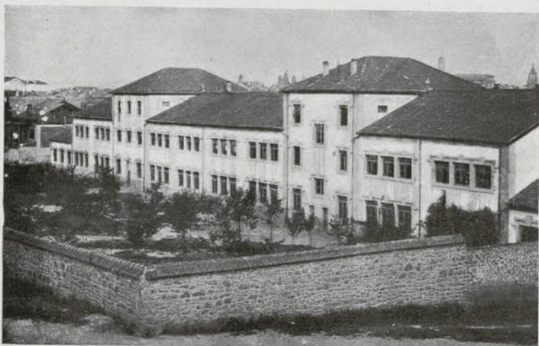
Vitoria. - Grupo escolar de "La Florida". Vista de la fachada sur. Contiene una graduada de párvulos, con seis grados; una graduada de niños, con tres grados; una graduada de niñas, con cuatro grados. Construida por el Ayuntamiento hace años, con subvención del Estado. Tiene todas las condiciones, menos calefacción.
