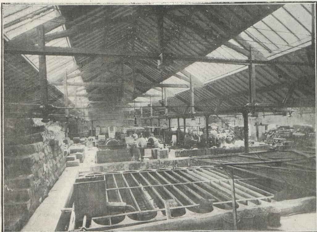
VISTA DEL SALÓN DE PILAS
