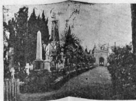
AVENIDA CENTRAL DEL CEMENTERIO INGLES.
