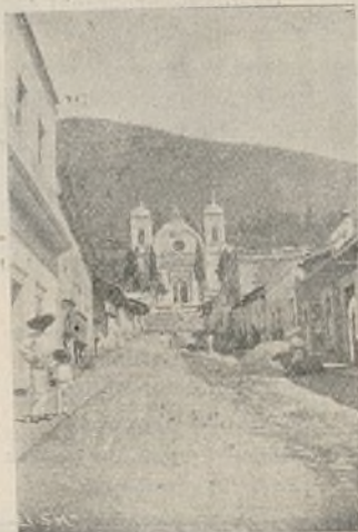
CAPILLA DE TENANCINGO
