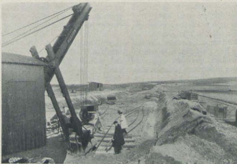
Un aspecto de las obras del Burgos-Madrid, en la sección de Lerma-Burgos.
