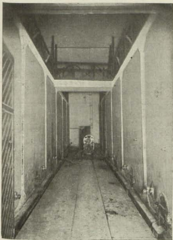
Una de las naves de conservación.
