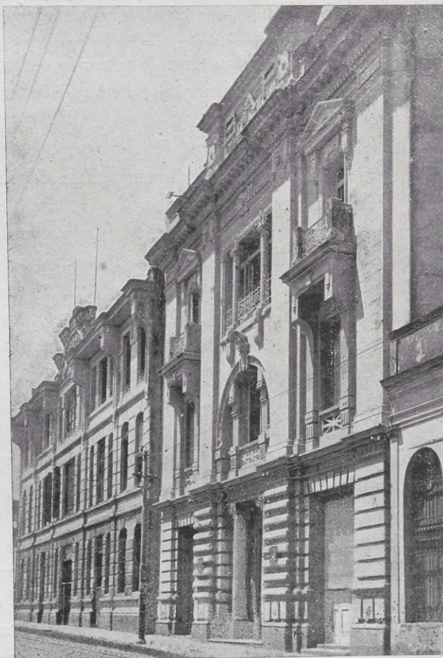
Asunción. -Fachada norte del edificio del «Banco Agrícola del Paraguay», institución Oficial del Estado
