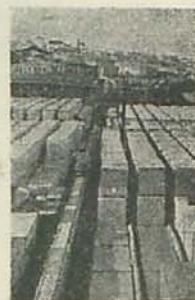
Bloques en el Puerto de Ceuta
