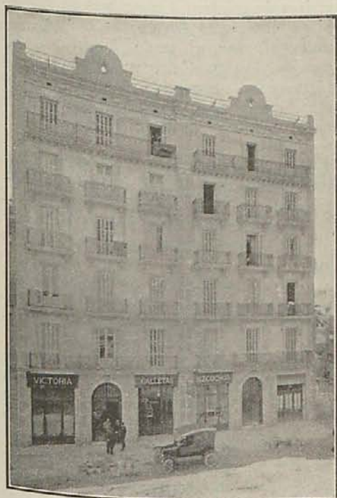
Fig. 51. — Casas de alquiler. Arquitectos Sres. Vega y March. Viguetas y planchés «Vilagut»
