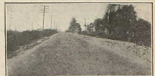
Una sección de la carretera de Cuyaboga
