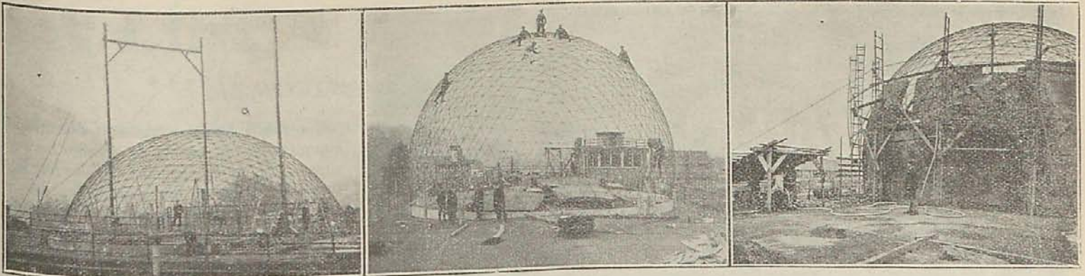
Armaduras metálicas de acero de las cúpulas continuas y relleno mecánico del hormigón por el aire comprimido
