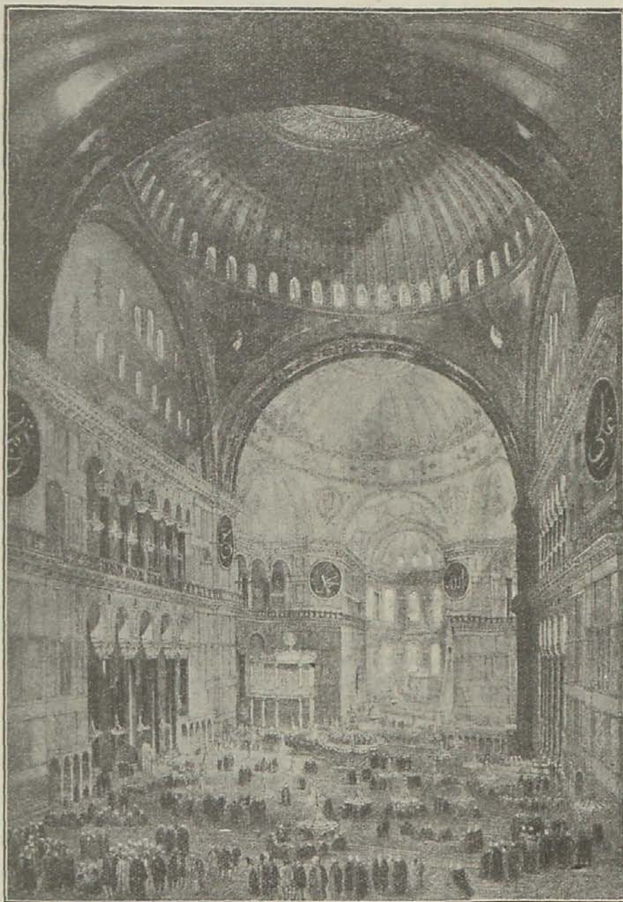
Vista interior de Santa Sofía de Constantinopla
