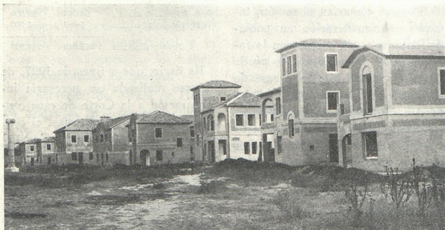
Una vista de la parte de Colonia en construcción, tomada desde la orilla del Manzanares.
