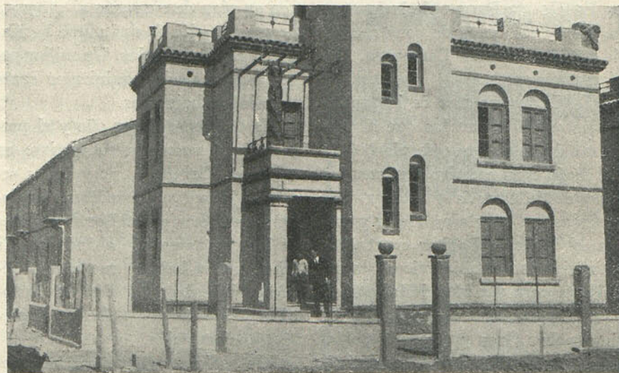
Modelo de hotel de dos pisos, aislado, ya terminado.
