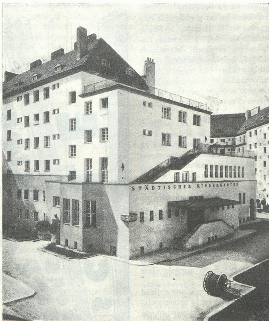
Vista parcial de otro grupo de viviendas, en el que la sencillez de líneas presta a la construcción gracia y belleza especiales.
