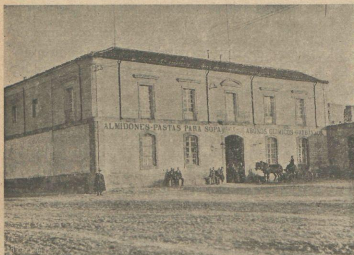
Fachada principal de la fábrica.
