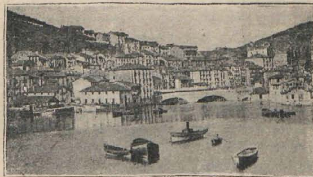
Ondárroa (Vizcaya) Dársena fangosa que al quedarse en seco produce muy malos olores, y casas de los pescadores
