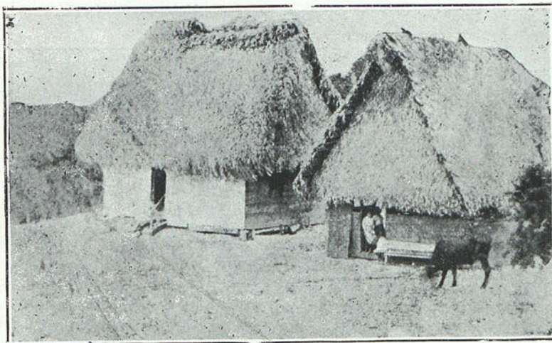
HONDURAS: Construcciones típicas de los indígenas.
