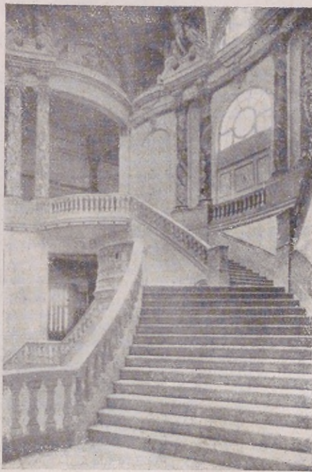
Vista de la escalera principal y entrada al Salón de Actos
