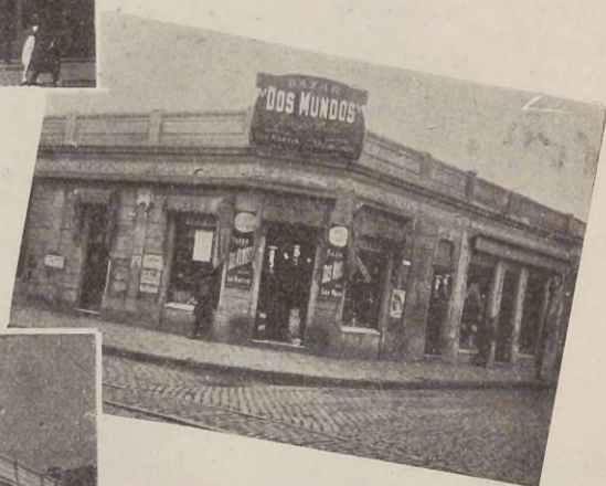
Esquina de Avenida del Trabajo y Varela donde se encuentra instalada la sucursal número 22.
