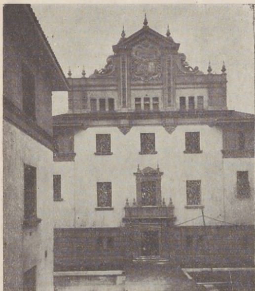
Frente de uno de los pabellones librado ya al servicio público.
