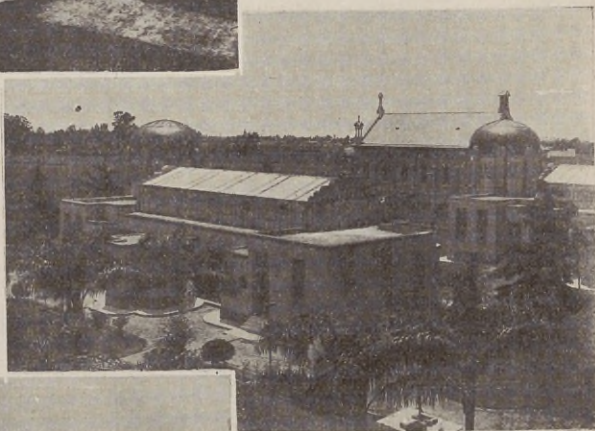
Vista de pabellones principales en el anexo.
