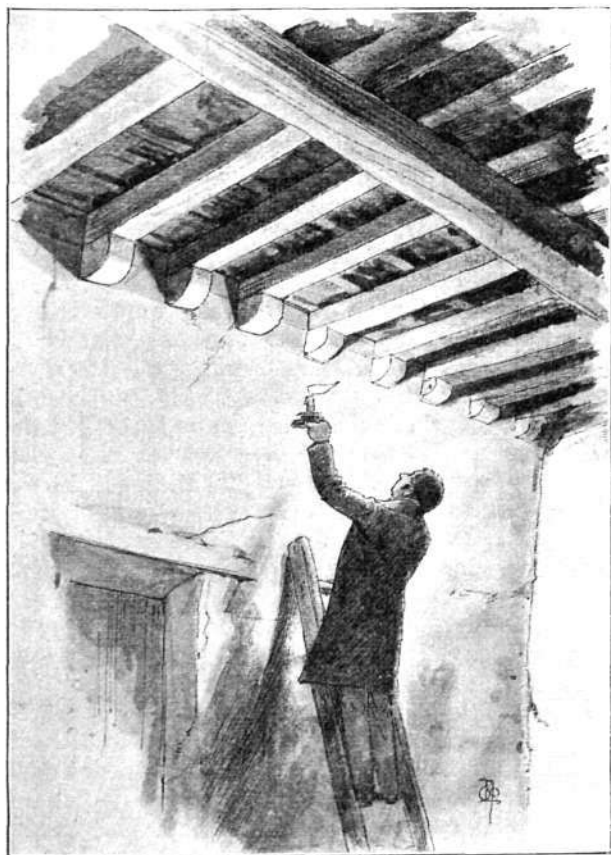
Sólo encontró Maroto, cubiertos de moho, los fusiles que depositara entre las vigas del techo.
