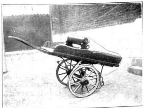
Carretilla empleada en los experimentos hechos por el autor de este artículo en la telegrafía sin hilos, utilizando las ruedas para la corriente de retorno.
