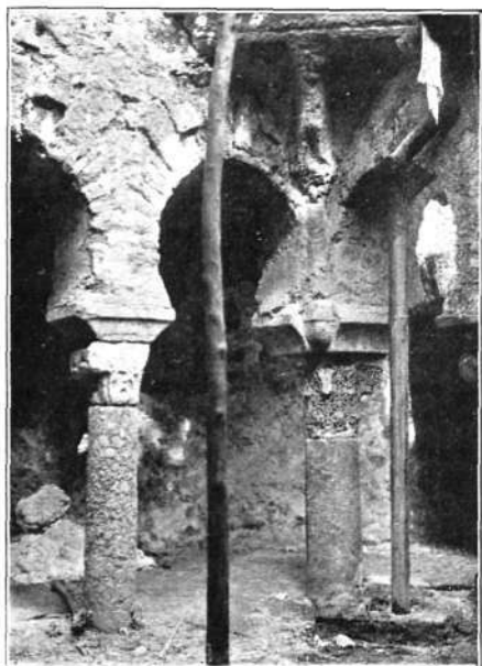
CÓRDOBA.—Ruinas de un baño musulmán en la casa núm. 8 de la calle de Carlos Rubio, antes llamada del Baño por esta típica construcción.
