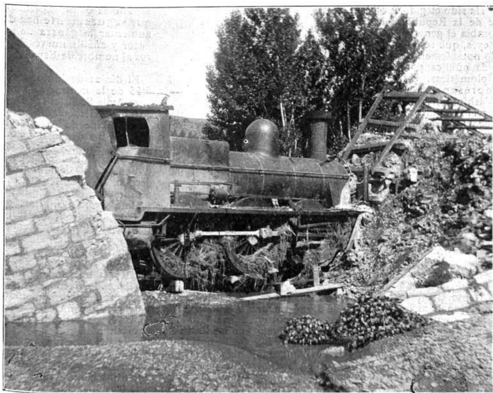
CATÁSTROFE DE ENTRAMBASACUAS (TERUEL).—La máquina del tren empotrada en el cauce del río, entre el terraplén del puente y su estribo.
