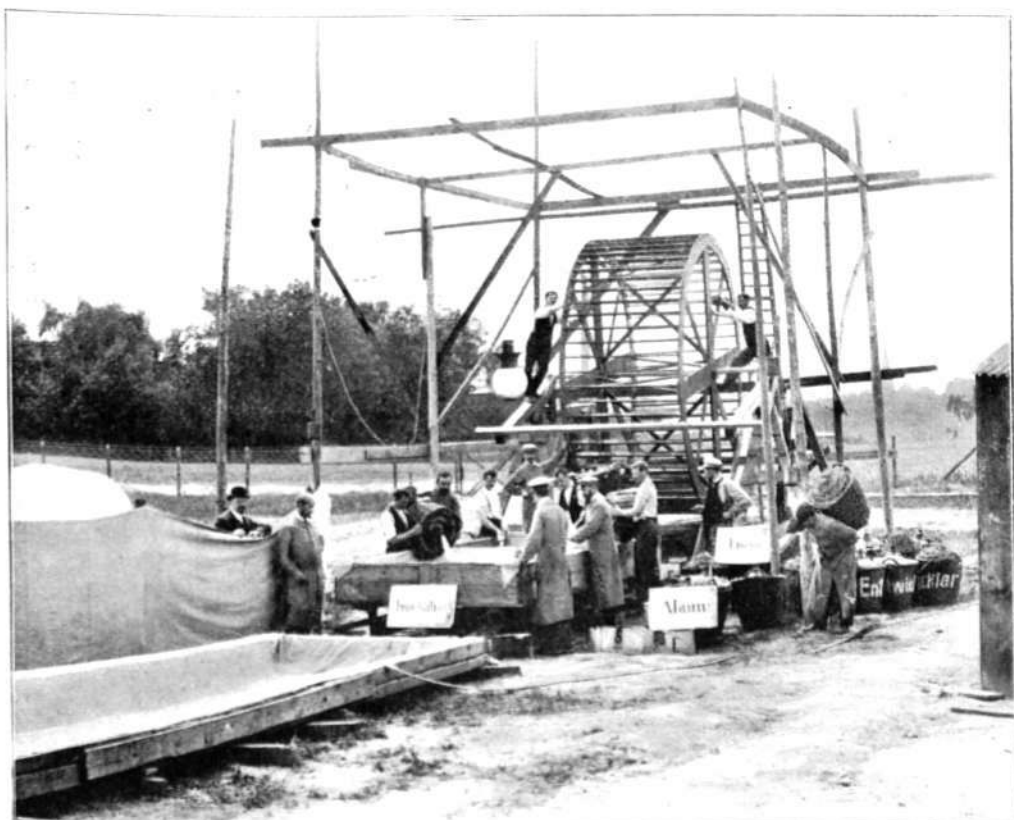
RUEDA Ó BOMBO DE LISTONES DESTINADO Á SOSTENER Y APROLLAR EL PAPEL FOTOGRÁFICO. Preparación de los baños para revelar, lavar y fijar la colosal fotografía de la ciudad de Nápoles expuesta al público en la Exposición de Dresde.
