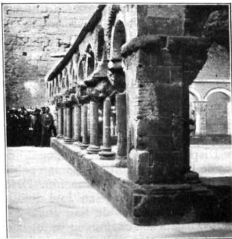
CLAUSTRO DE SAN JUAN DE LA PEÑA. Galería del claustro del monasterio antiguo.
