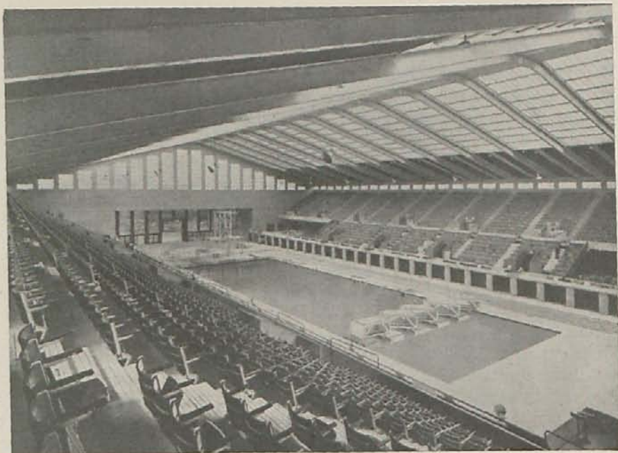
Aspecto de conjunto del interior
