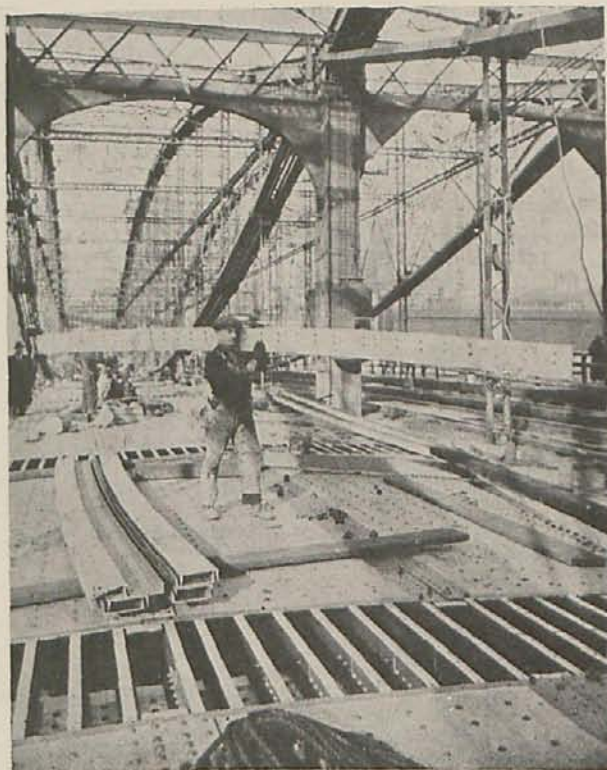
Se ven claramente en esta fotografía los paneles del planchado, montados en el taller y llevados en una pieza a pie de obra.
