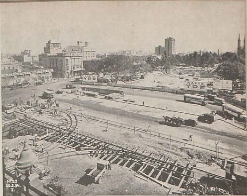
Vista de la Plaza Constitución, desde la fachada de la Estación del F. C. del Sur. Aspecto de la construcción de la estación del subterráneo, en el mes de abril último. El tráfico se hace sobre el techo de la estación del subterráneo, ya terminada, faltando únicamente la parte que se ve en zanja.
