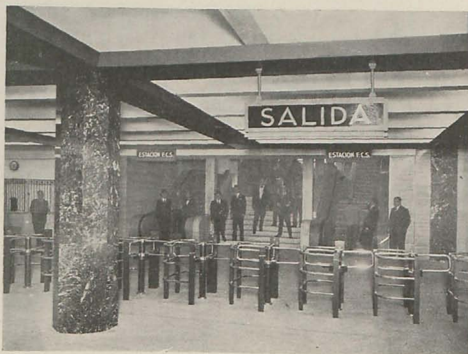
Escalera fija de entrada y dos escaleras móviles en el andén de cabeza de la estación Constitución. Se aprecia el alumbrado indirecto, que da grandes proporciones a la gran superficie cubierta con techo plano, y los pilares revestidos de mármoles. Estas escaleras conducen al vestíbulo de la estación de F. C. S., como puede apreciarse en la fotografía.
