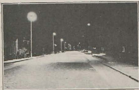
Carretera de Vught (Holanda). PHILORA 100 W.
