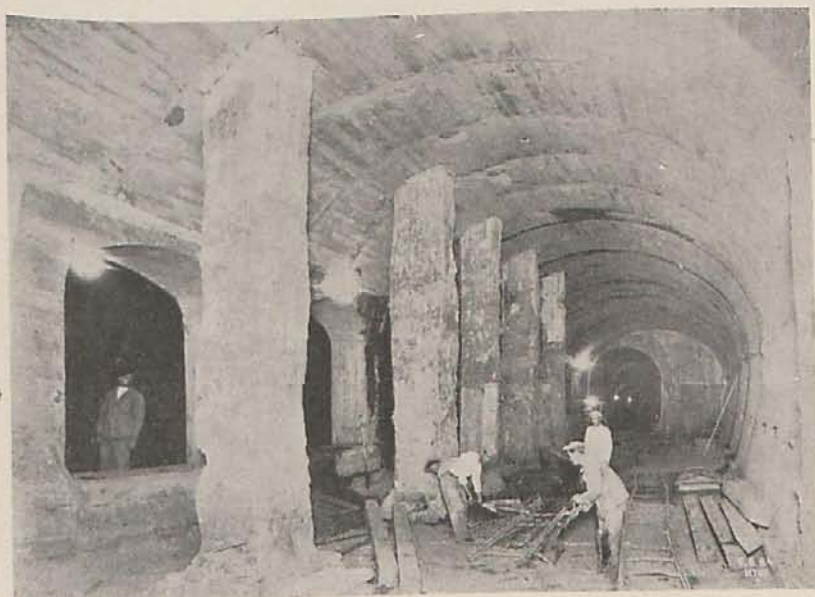
Pilares provisionales para apeo de los edificios situados sobre la bóveda Oeste de la estación Avenida de Mayo. Una vez certados dichos pilares, los edificios quedan apoyados por la bóveda de la estación. Junio, 1934.
