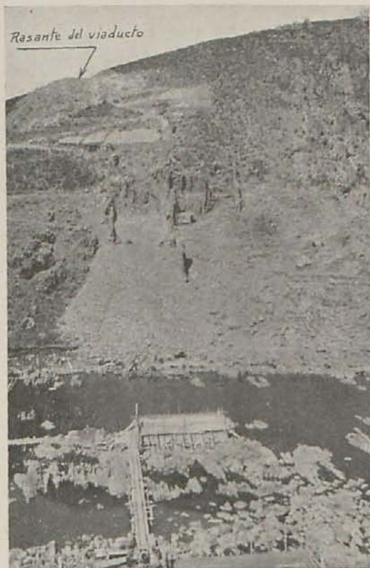
Estribo de la margen derecha.
