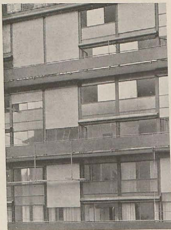
Fig 15. — Edificio en Auteuil.
