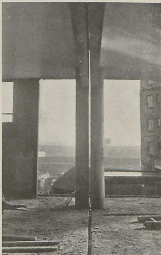
Fig. 12. - Una junta de dilatación.
