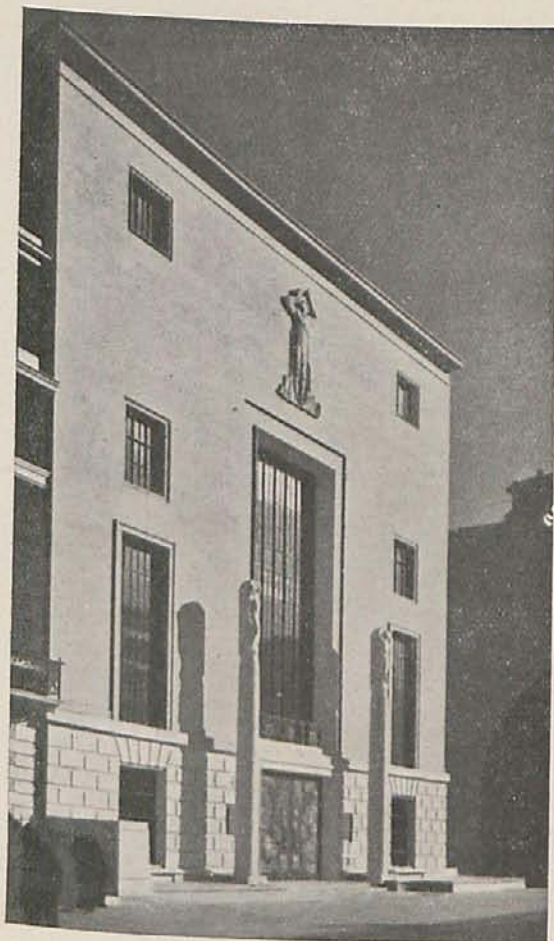
Fachada principal del nuevo edificio del Royal Institute of British Architects, de Londres. La estructura es metálica y las fachadas de piedra de Portland.
