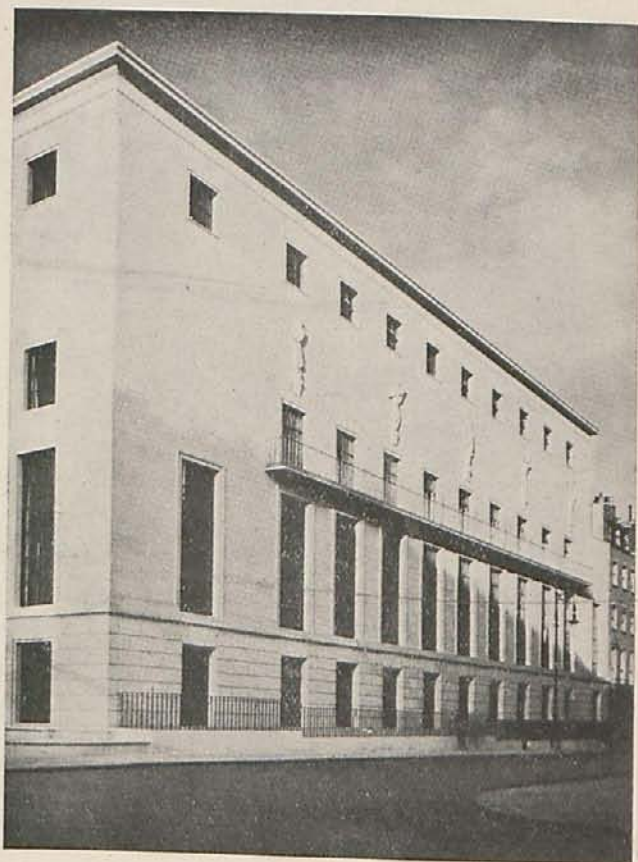
Fachada lateral del edificio del R. I. B. A. Los cinco alto-relieves de esta fachada representan al arquitecto, al pintor, al escultor, al mecánico y al obrero.
