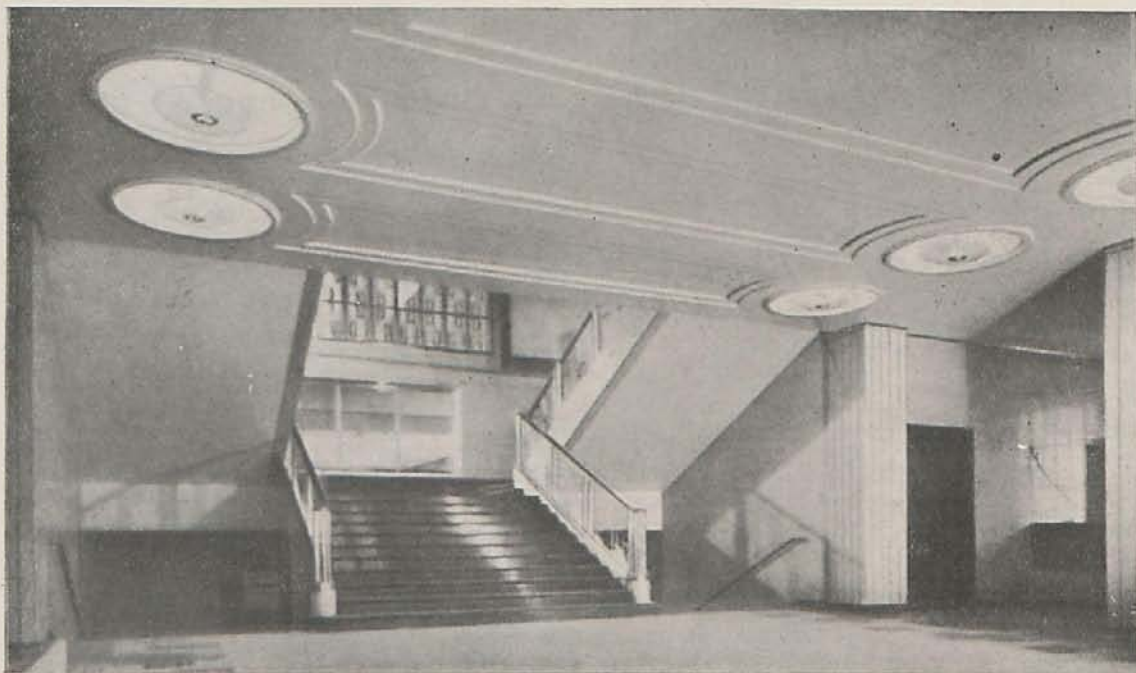
Hall y escalera principal.
