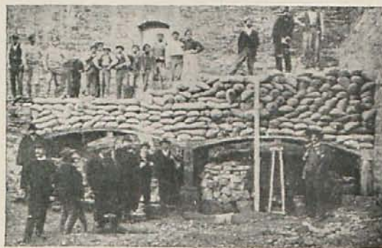
Fig. 2. a —Pruebas de la cubierta del Depósito de Gijón.
