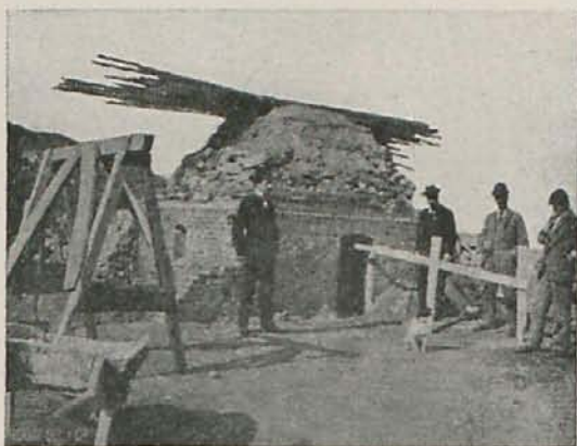
Fig. 1.ª—Experiencias de un forjado en Oviedo.
