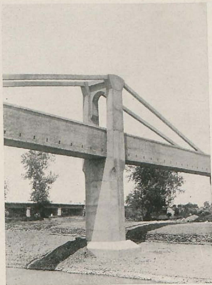
Fig. 6.*.-Acueducto de San Patricia, en Jerez.
