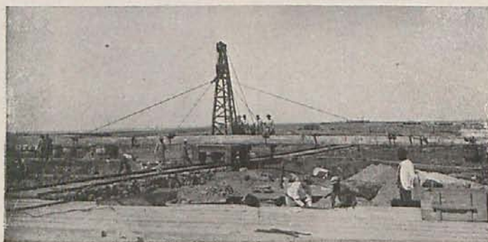
Fotografía (C).—El carretón conduciendo el pilote al entramado de carga.
