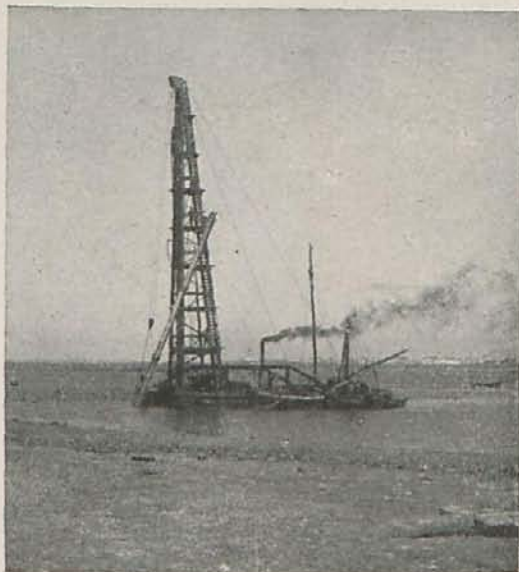
Fotografía (F).--Fase final para poner vertical el pilote.
