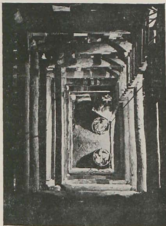
Un pozo de entrada a las galerías de recalce de cimentación.
