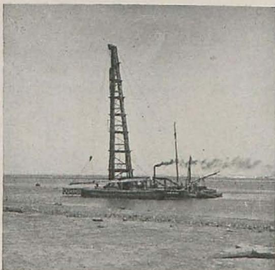
Fotografía (E).--Levantando un pilote de la gabarra.
