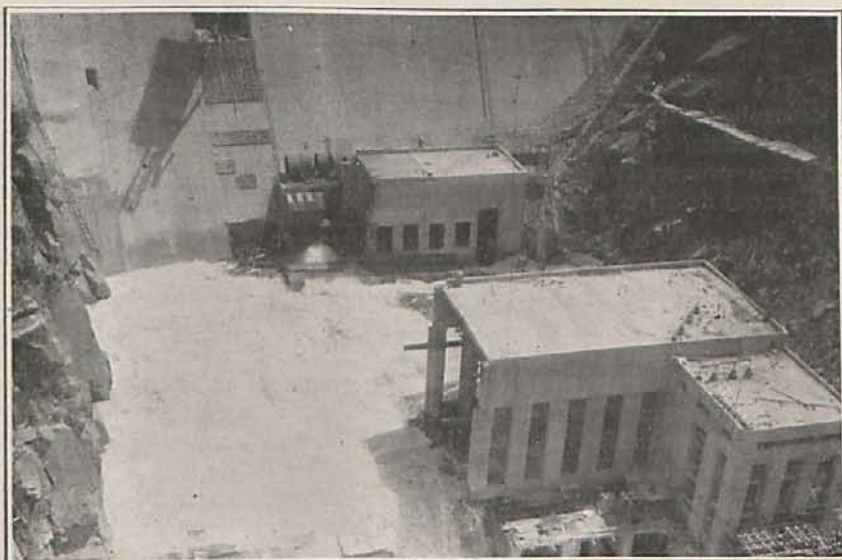
Recinto de fundación de los grupos 3 y 4 inundado por las aguas que salen de la tubería 4. Instante en que la tubería funciona como canal de lámina libre.
