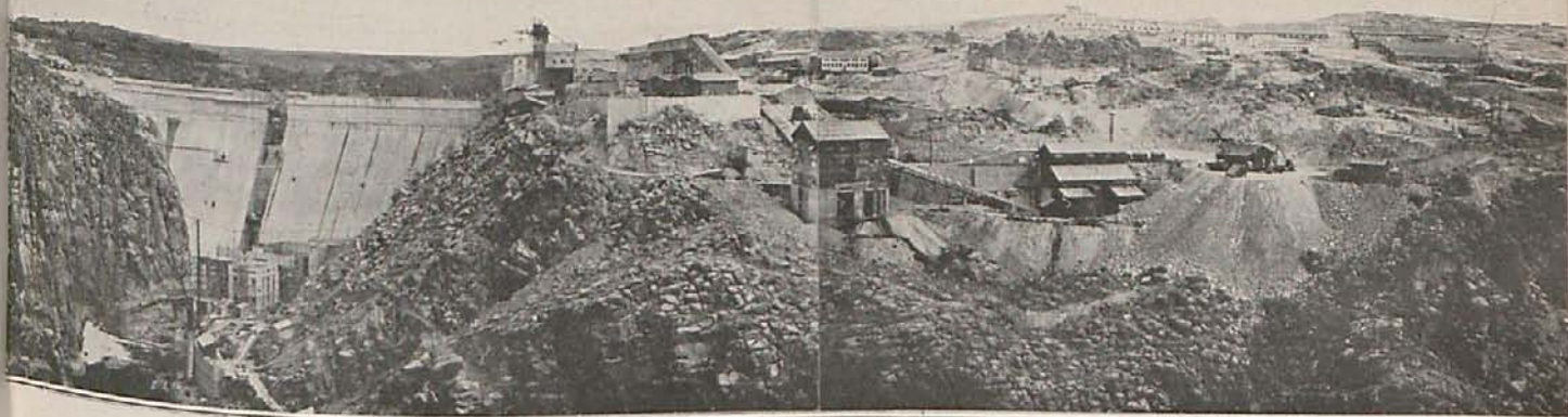
Las obras del salto del Esla en el verano de 1933. En el centro de la presa el portillo que se dejó para el paso de las aguas durante la construcción.
