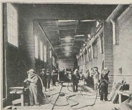
Fig. 20.—Taller de desoxidación por chorro de arena.
