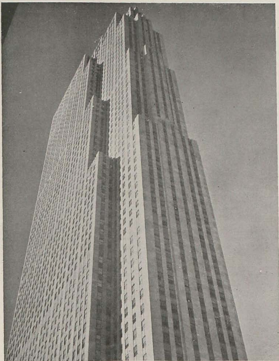
Curiosa vista del edificio de la Radio Corporation en Nueva York.
