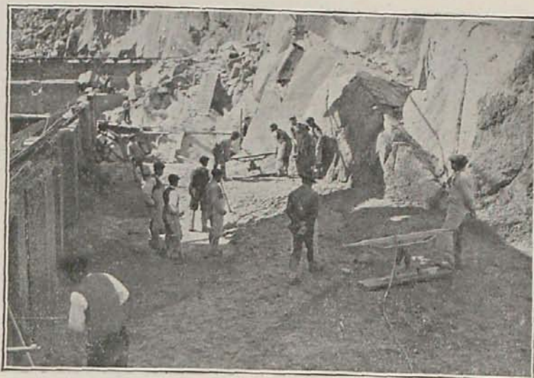
Fig. 4.—Vista de un tajo de hormigonado.
