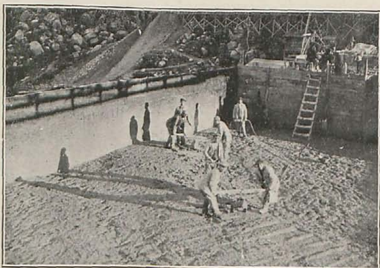
Fig. 5.—Capa de hormigón recién vibrado.
