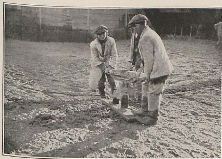
Fig. 6.ª—Detalle del apisonado del hormigón.
