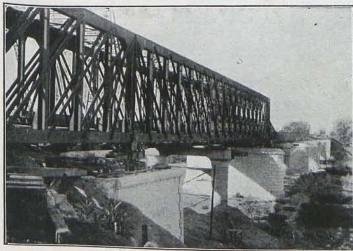
Corrido del nuevo puente.
