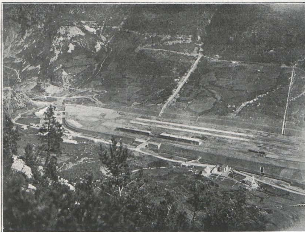
Explanada de la Estación Internacional. Río Aragón, canalizado, y torrentes Cargates y Epifanio, desviados y canalizados.
