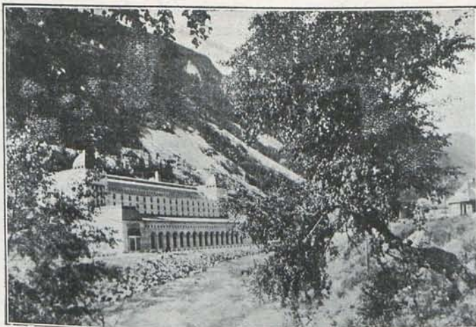
Central de fuerza en Rjukan.
