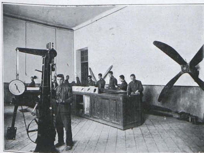
A la izquierda un soldado ensaya con la máquina correspondiente la resistencia de un cable. A la derecha se ve el aparato que sirve para equilibrar las hélices. Sobre la mesa las plantillas con que unos soldados van comprobando la exactitud de los perfiles.
