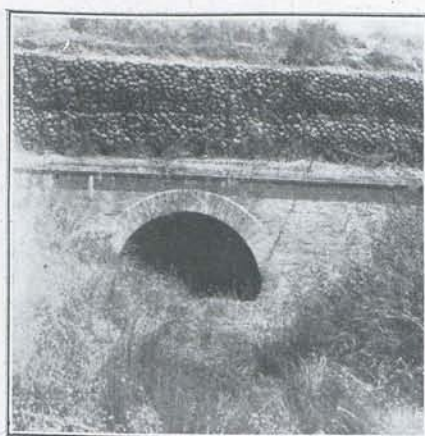
Figura 10.ª Alcantarilla de Zocaica.
