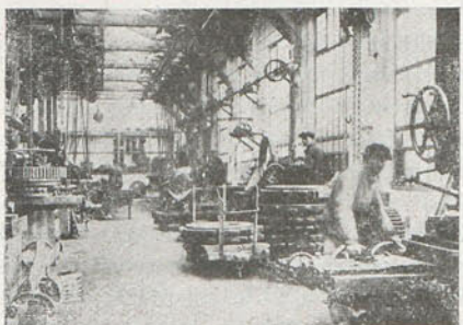
Vista del taller mecánico para moldes
