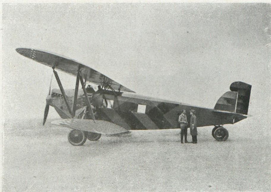
Un aparato Heinkel de transporte, tipo H.D. 40, motor B.M.W. 465 HP.
