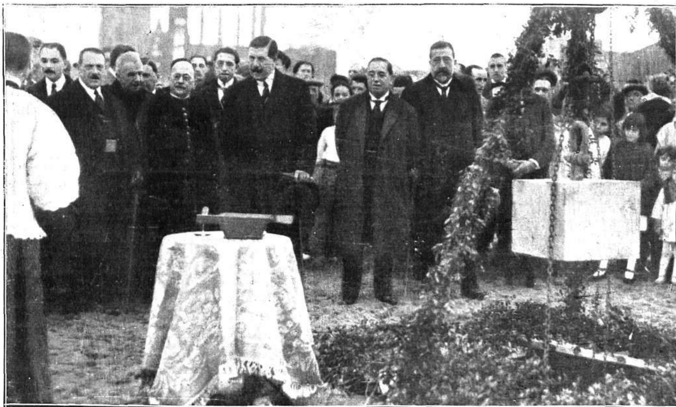
El ministro del Trabajo, con el alcalde, Sr. Martínez Domingo, y las autoridades civiles, militares y eclesiásticas, colocando la primera piedra para construcción de casas obreras en el barrio de la Sagrada Familia.
