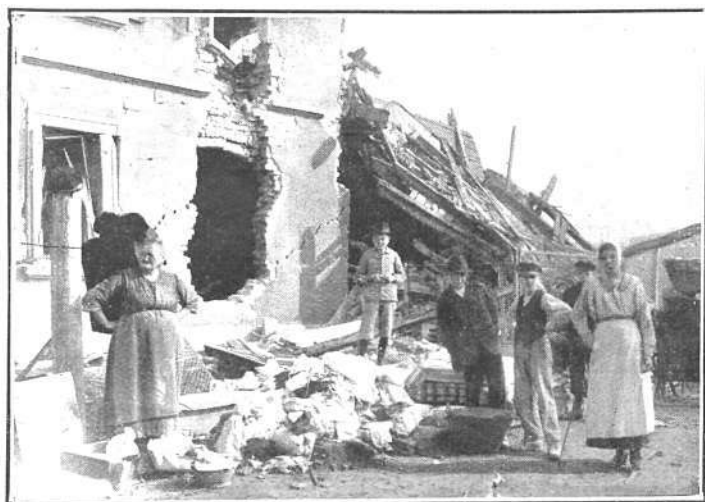
Estado en que quedó una de las casas inmediatas a la fábrica donde ocurrió la terrible explosión.
