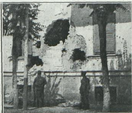
Efectos de un obús en la fachada de una casa del boulevard Hamidieh
