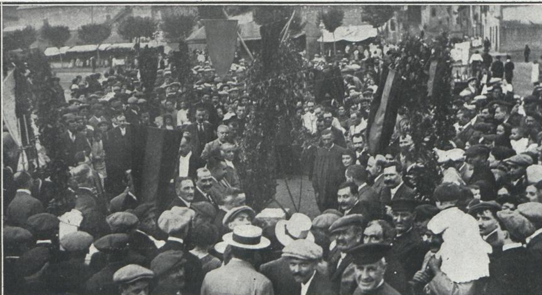
TARRASA.—Colocación de la primera piedra del edificio destinado a «Grupo Escolar»
