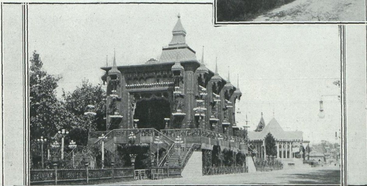
Vista de algunos edificios de la feria
