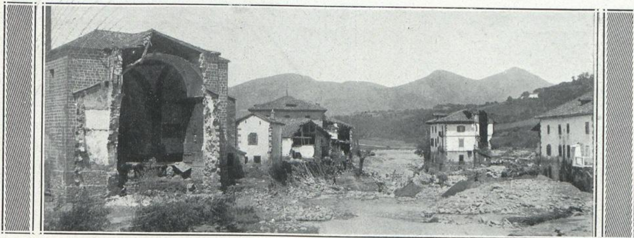
Estado en que quedó la iglesia de Errazu y en segundo término casas y puentes destruidos
