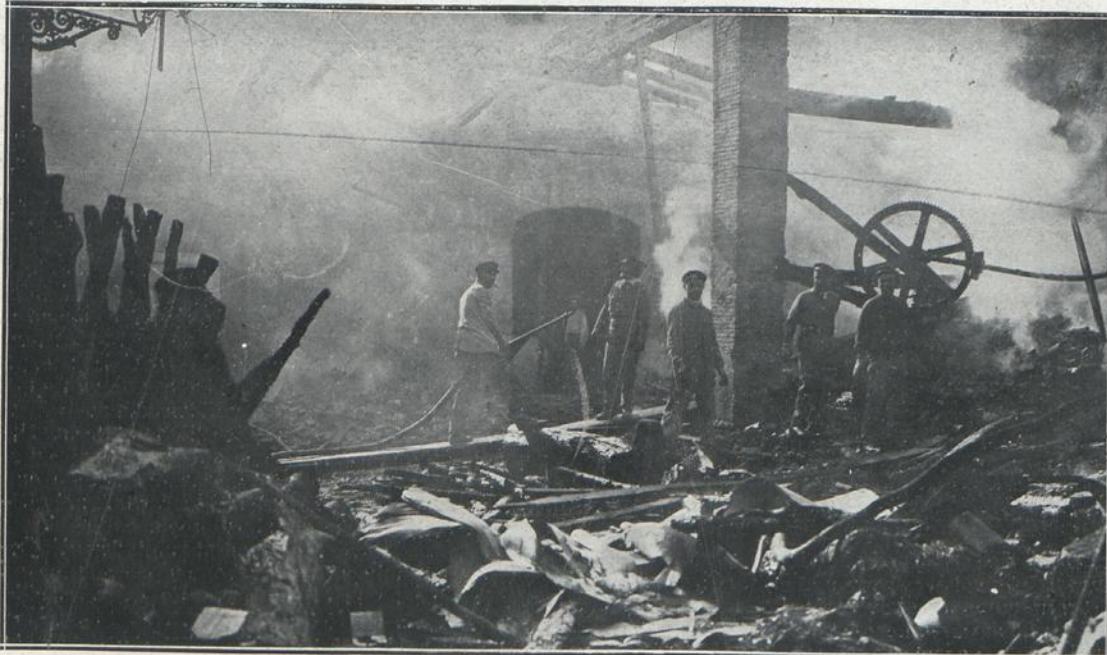
TARRAGONA.—La fábrica de muebles del señor Aleu después del incendio.—(Fotog. Vailly)
