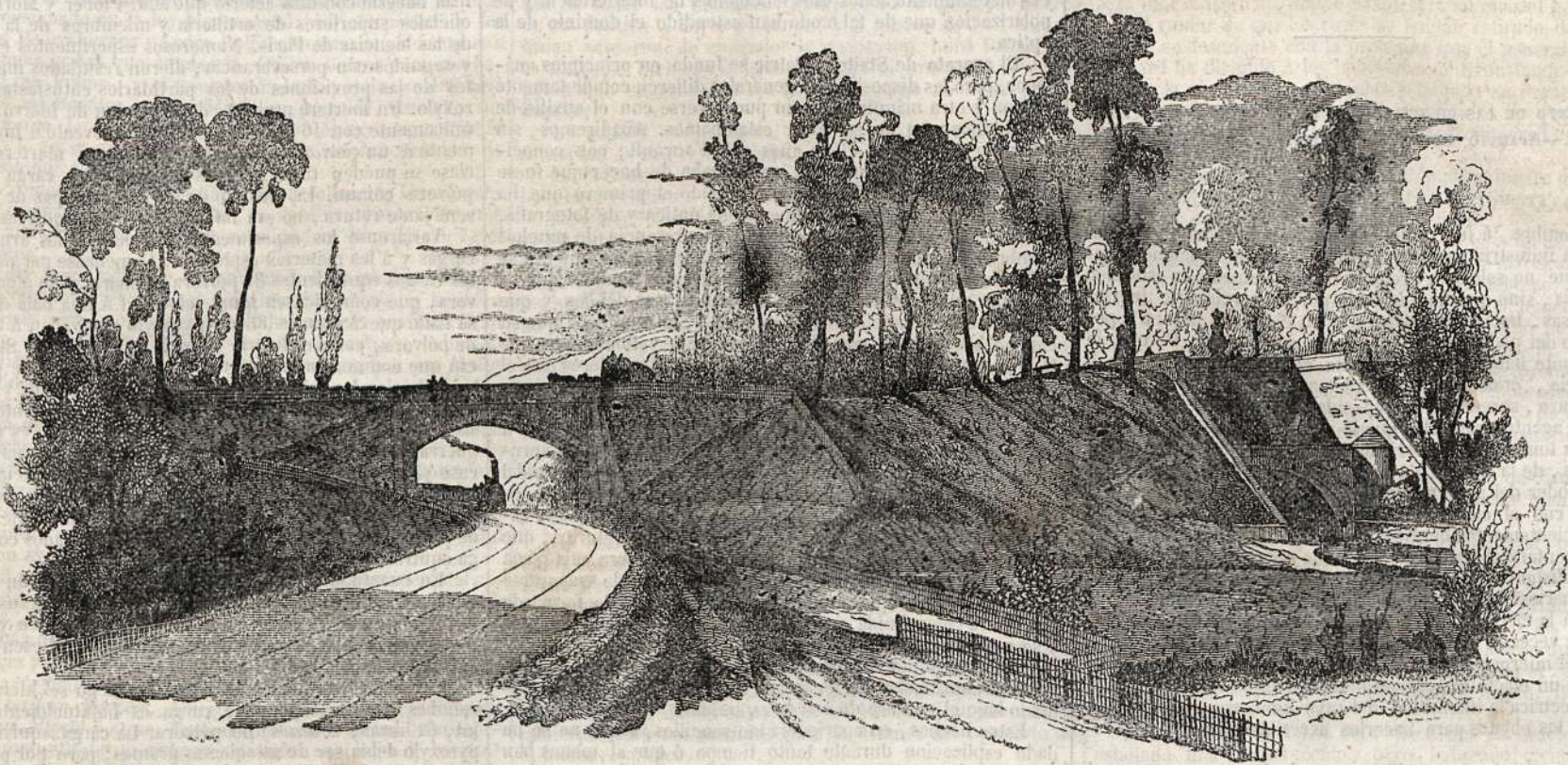
Paso del Ferro-carril por debajo del Camino Real.
