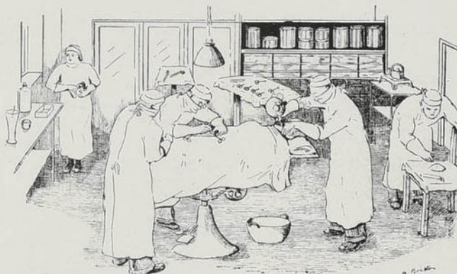
Vista de uno de nuestros quirófanos.
